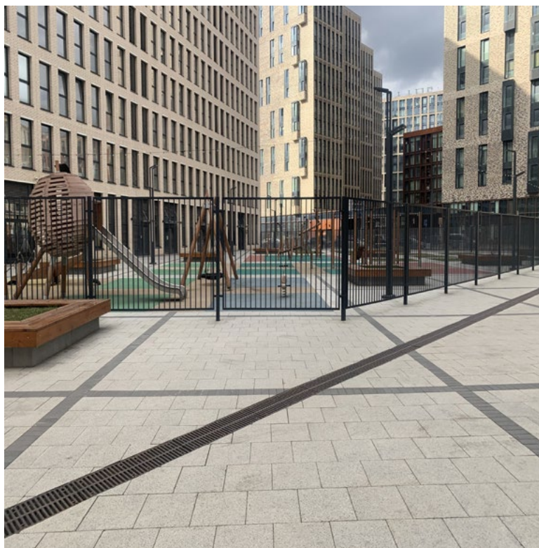
г. Москва, жилой комплекс
