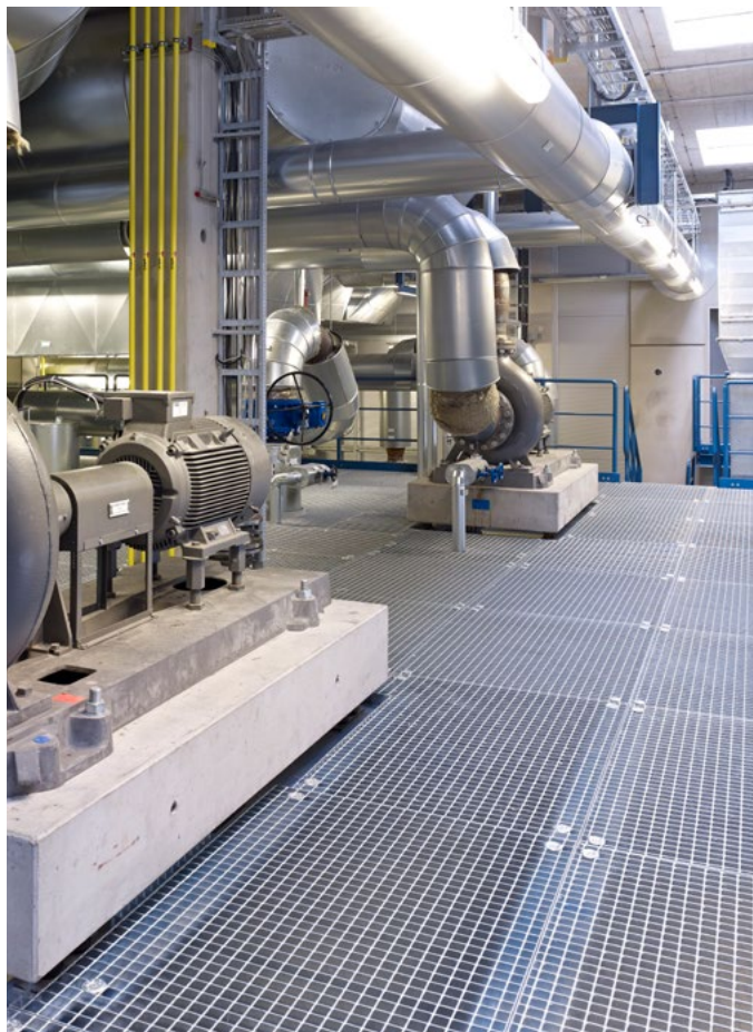
г. Новосибирск, производственные помещения, сварной настил
