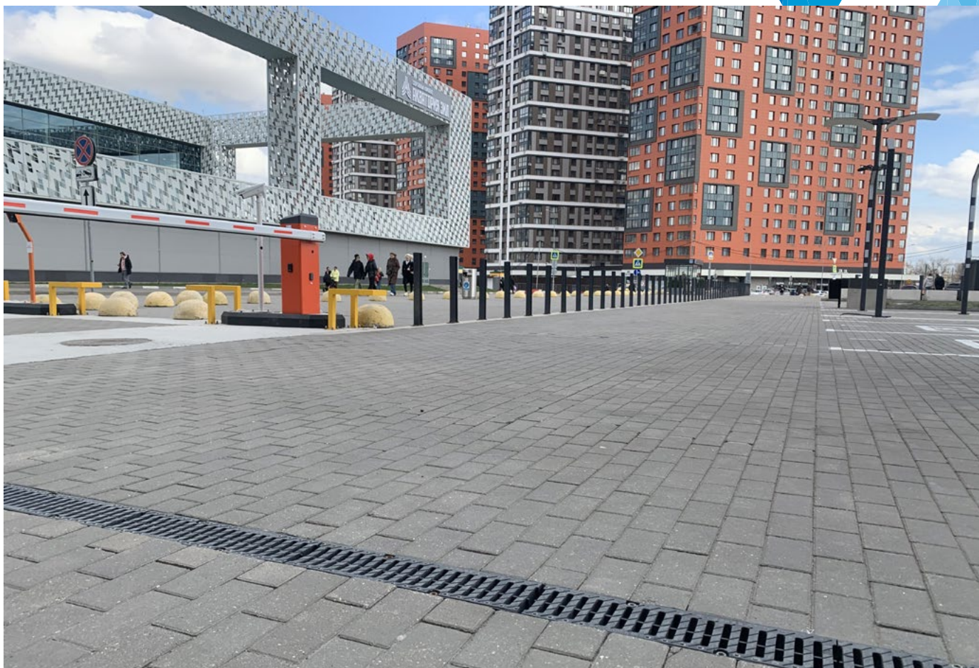
г. Москва, ЖК “Зиларт”, паркинг, пластиковые лотки Gidrolica Pro
