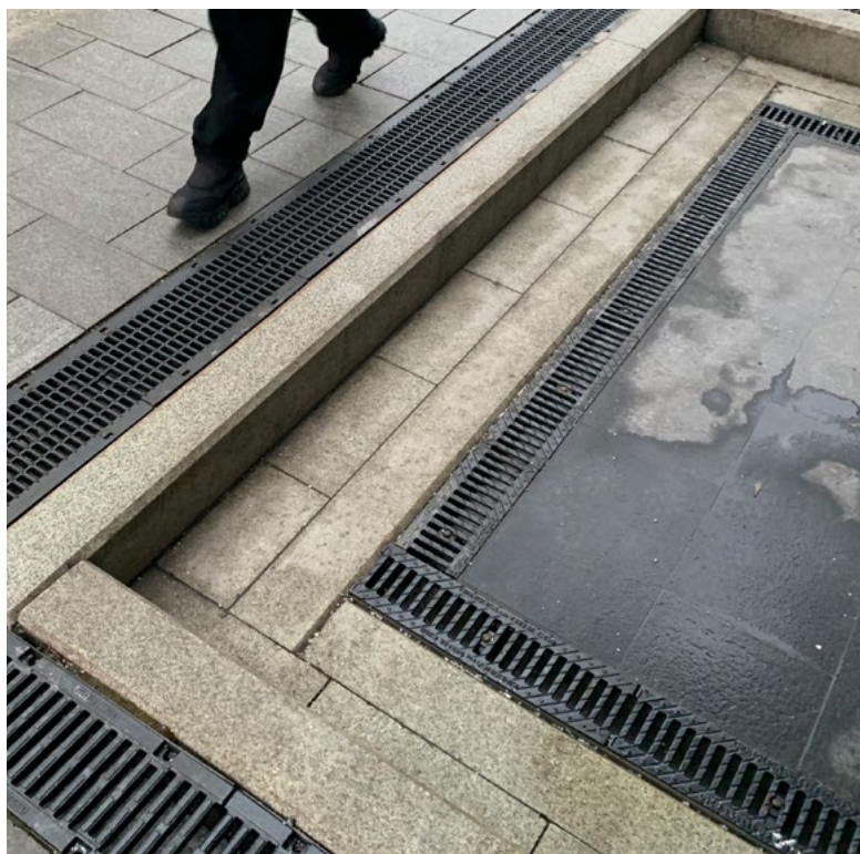
г. Москва, ул. Большая Полянка
